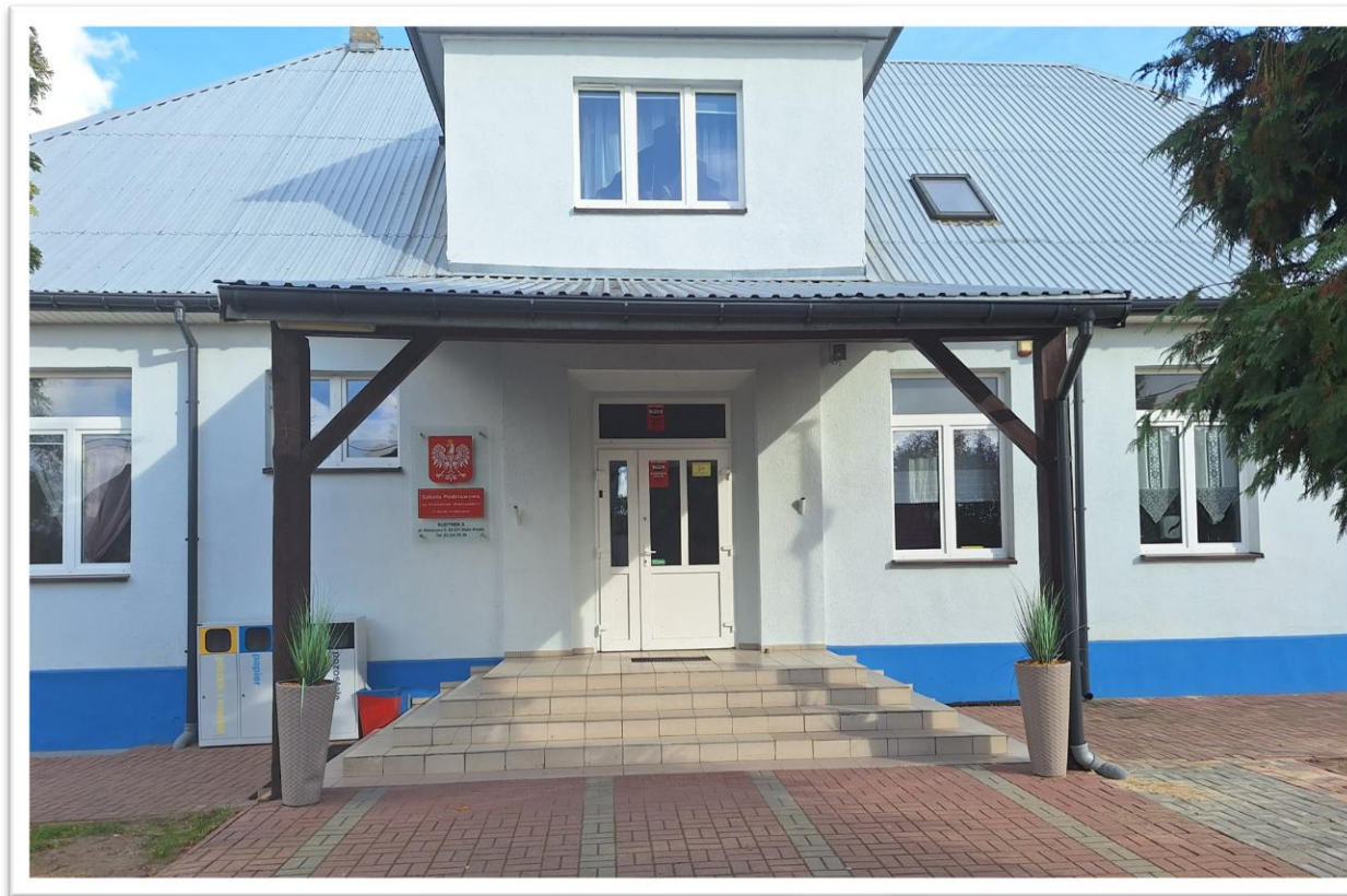
Budynek szkoły podstawowej
